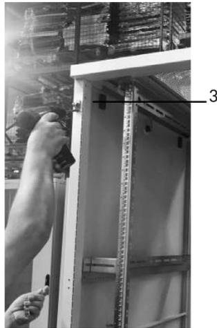
Teile des Mechanismus-Stangenhalters werden auf der anderen Seite angebracht.
