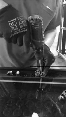
Das Schloss wird entfernt durch Lösen der 2 oben gezeigten Schrauben.
