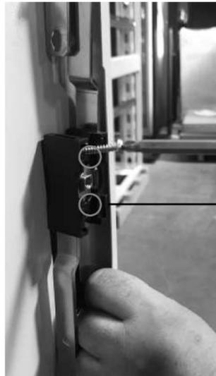
Die Richtung der Sperre wird geändert. Schrauben werden wie abgebildet montiert.
