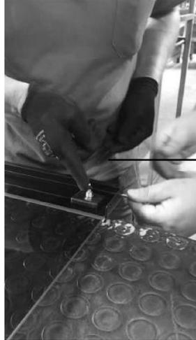
Die entfernten Scharnierteile werden auf der anderen Seite der Tür angebracht.
