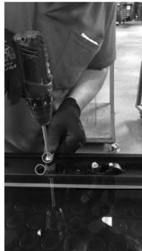
Die Richtung des Schlosses wird geändert. Die Schrauben werden montiert wie abgebildet.
